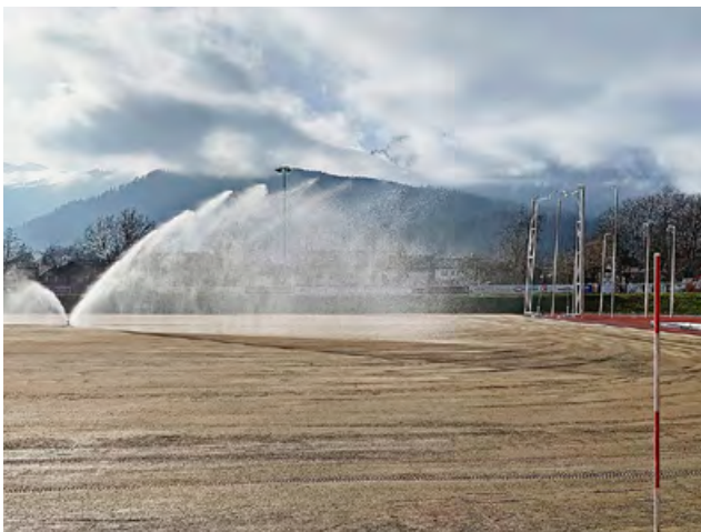
Test der Beregnung und Vorwässerung für die Rollrasenverlegung
