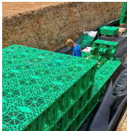
Einbau einer Rigole im felsigen Untergrund
