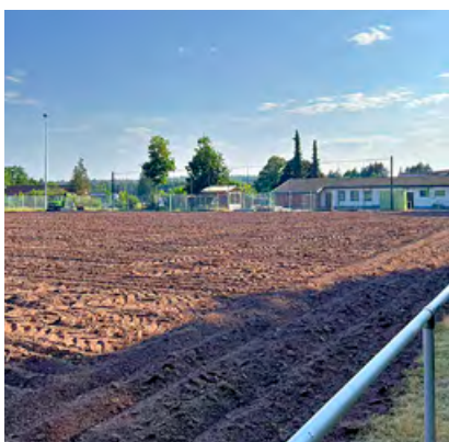
Einarbeiten des vorhandenen Tennematerials in die dynamische Schicht
