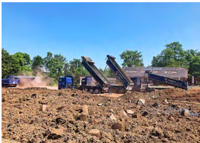
Umfangreiche Erdbewegungen mit über 600 LKW-Ladungen
