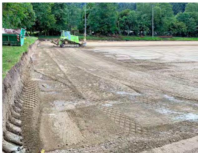
Umfangreiche Geländemodellierungen für die neue Höhenlage
