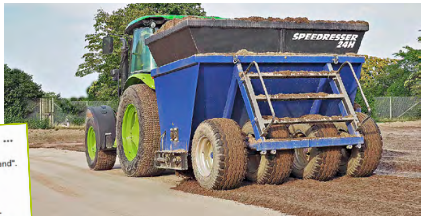
Einbringen der zusätzlichen Rasentragsschicht in mehreren Arbeitsgängen
