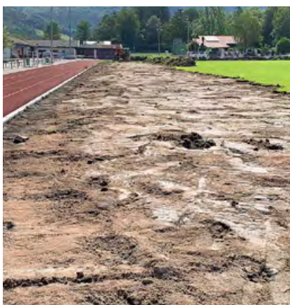
Abtrag der alten Deckschichten
