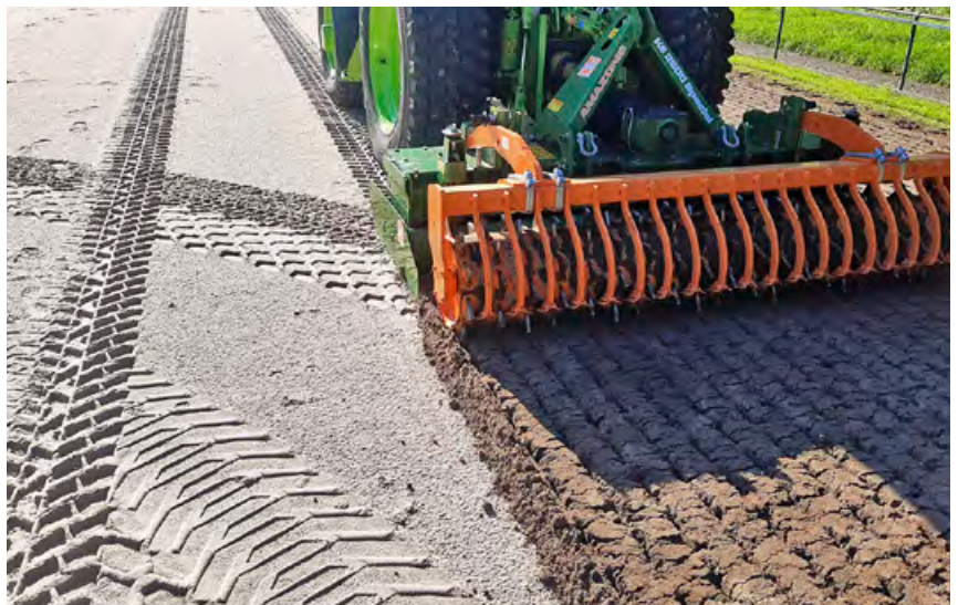
Einarbeiten des frischen Sands in die vorhandene Rasentragschicht
