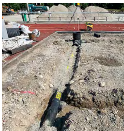
Leistungsverlegung gemäß neu erstelltem digitalem Höhenmodell
