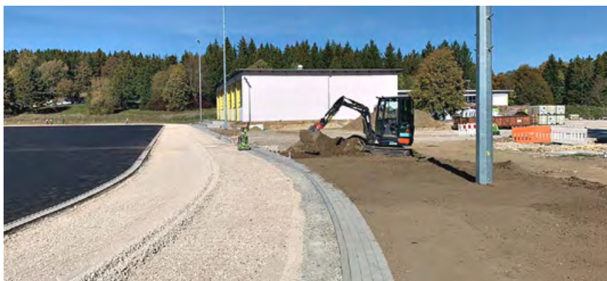
Neu angelegte Laufbahn mit umlaufendem Pflasterstreifen
