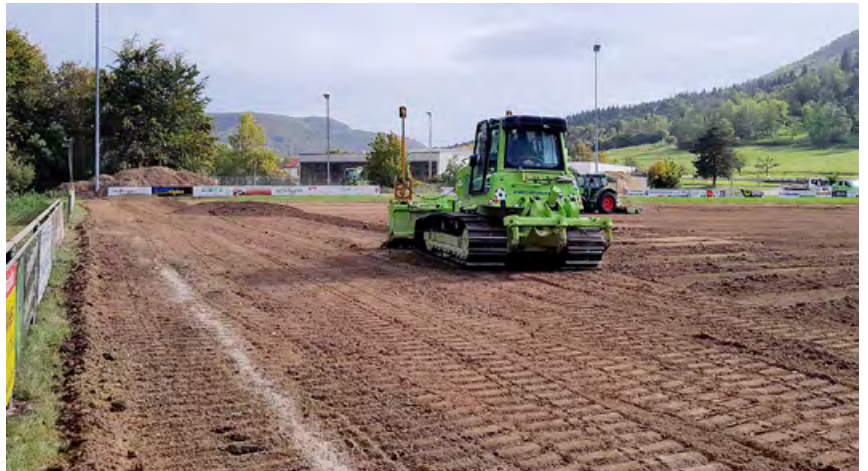
Herstellen des Planums nach dem Abfräsen – zum teilweisen Ausgleichen der Höhendifferenz
