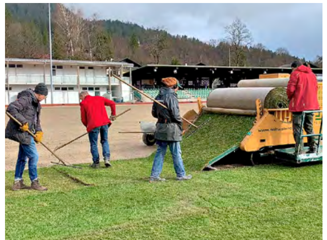
Rationell und trotzdem zentimetergenau: Verlegung der Rasensode
