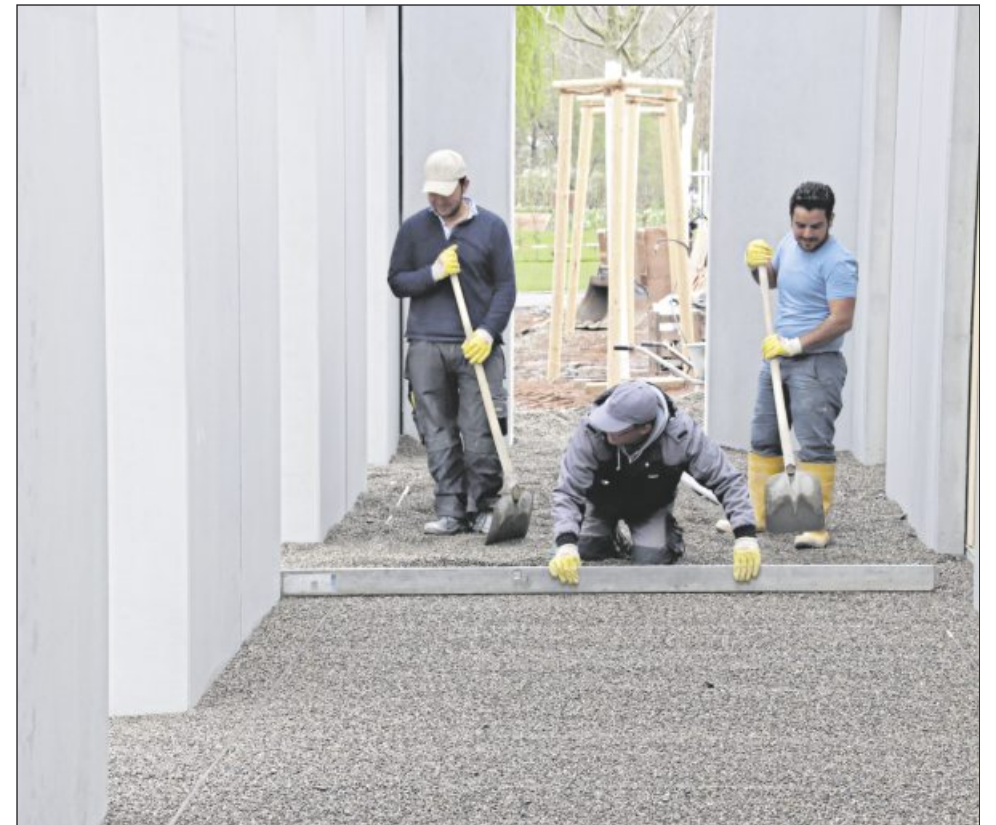
Auf dem Gelände der Bundesgartenschau wird noch heftig gebaut.
