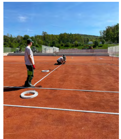
Linierungsarbeiten auf Platz 1 und 2
