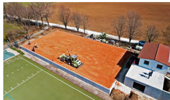
Blick auf den Platz mit frischer planierter Ziegelmehlschicht, daneben der neue Technikraum mit Sonnenterrasse
