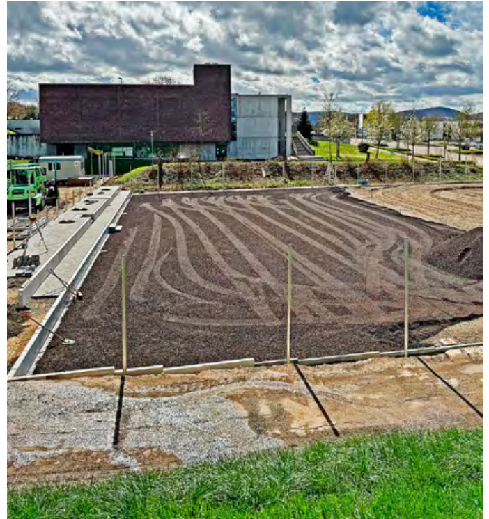
Links Platz 3 und 4, abgetrept mit 50 cm hohen Mauerscheiben, rechts Platz 1 und 2. Den Geländeversprung nutzen wir mit einer neuen zweireihigen Sitztribüne.
