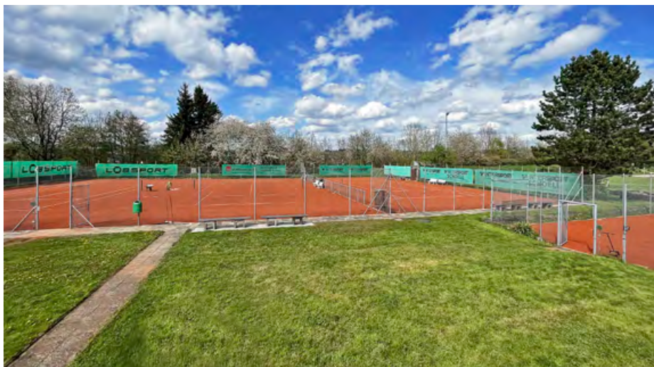
Vier komplett sanierte Sandplätze bei den Tennisfreunden Böbingen
