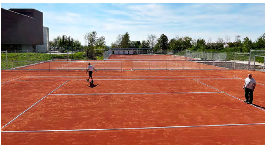
Blick über die sanierten Plätze 1 bis 4 mit neu eingemessenen Spielflächen
