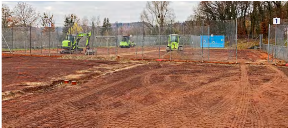
Ausbau der alten Deckschichten (Bild oben), neuer Sauberkeitsstreifen, Entwässerungsrinne und Versenkreger im Schutzring (unten)
