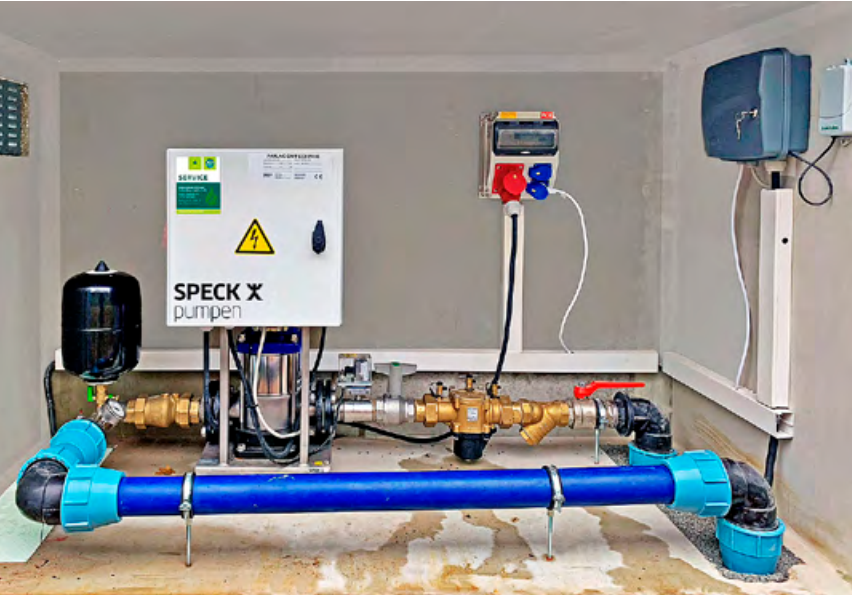
Einbau der Pumpenanlage einschließlich Druckerhöhung und Steuergerät in vorhandene Betonbox
