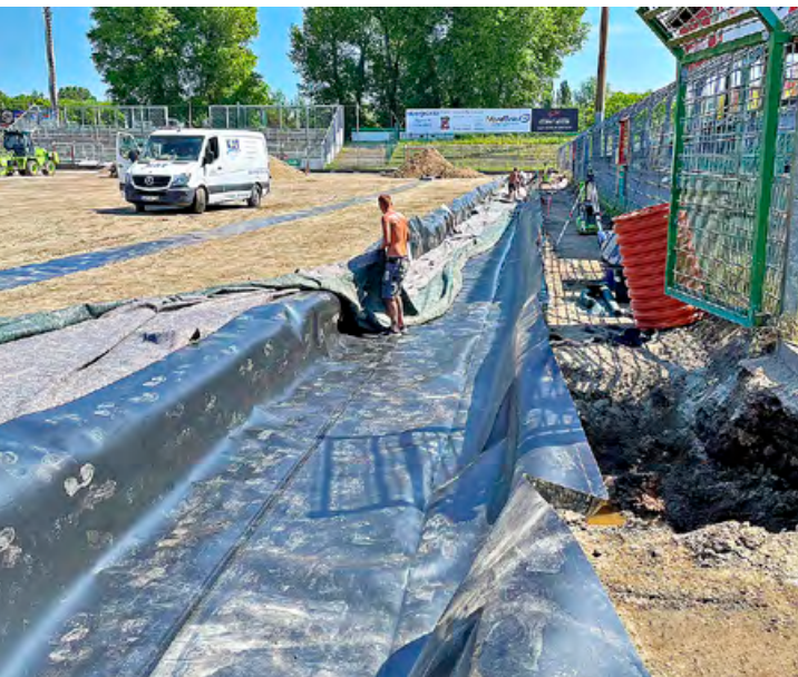
Einbau einer Rigole an der Längsseite als Zwischenspeicher für überschüssiges Oberflächenwasser
