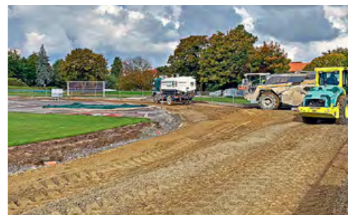
Schweres Gerät für tragfähigen Baugrund
