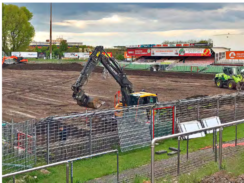
Abtrag von rund 10.000 t Erdmaterial auf einer Gesamthöhe von 50 cm
