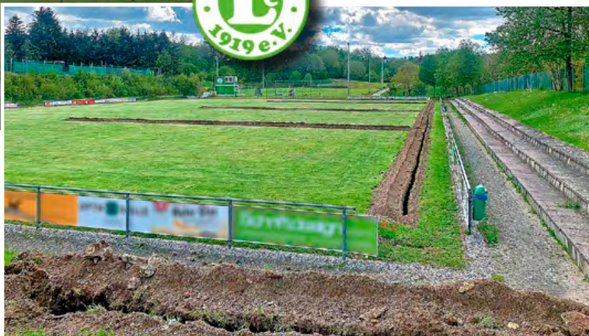
„Minimal-invasiv“: Leitungsgräben für versenkte Vollkreis- und Randregner
