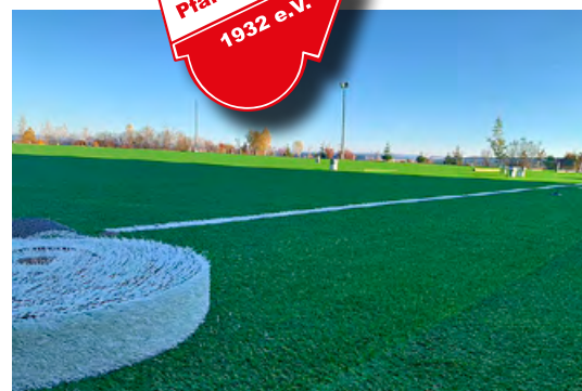
Frisch verlegter Kunstrasen mit Korkgranulat in VS-Pfaffenweiler
