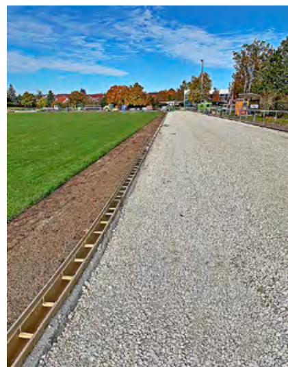
Laufbahn mit Kastenrinne, Schottertragschicht
