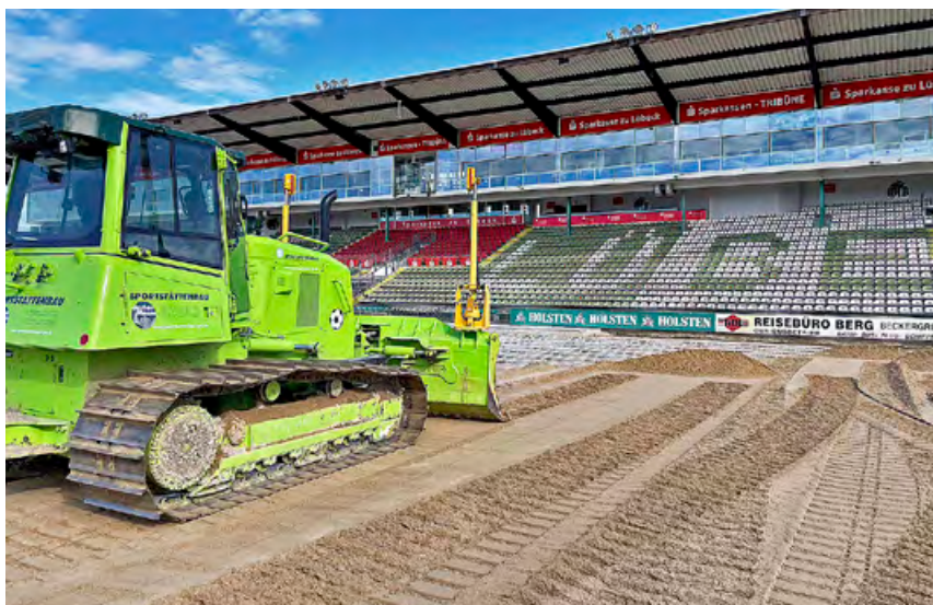
Lasergesteuertes Einbringen der 15 cm starken Dränschicht auf der Rasenheizung
