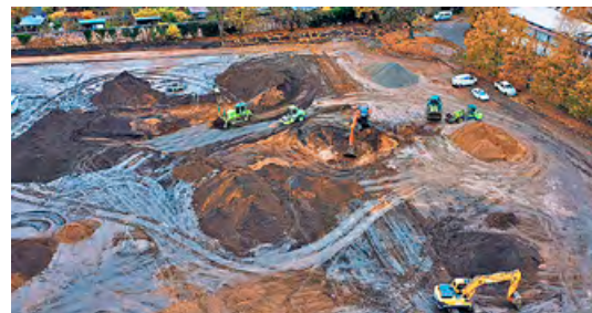
Ausbau des mit Kriegsschutt belasteten Untergrunds
