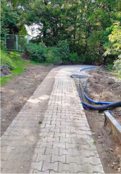
... und neue Hauptzuleitung vom Schacht an der Schwimmhalle
