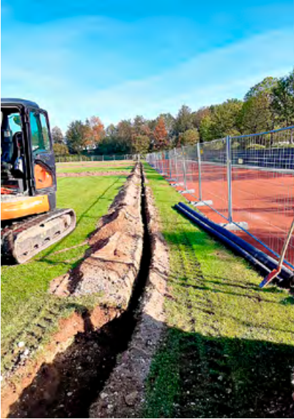
Gräben für neue Bewässerungsleitungen ...
