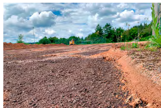
Alte dynamische Schicht unter der alten Tennendeckschicht
