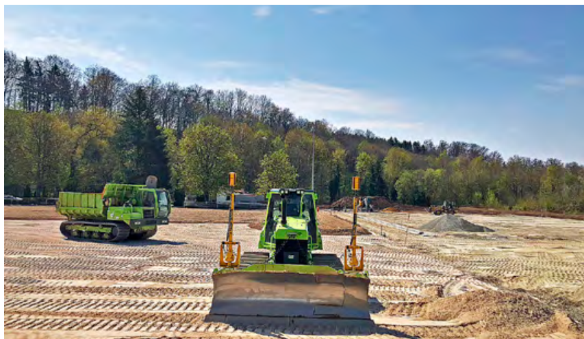
Neubau des Hauptspielfelds mit 8500 m 2 und eines Kleinspielfelds mit 2400 m 2
