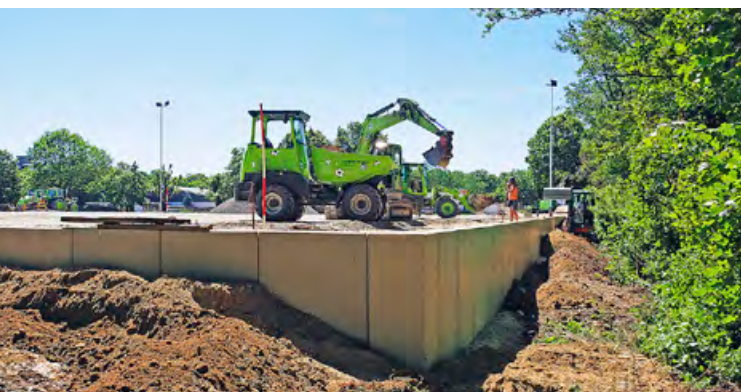
Geländemodellierung auf 75 m Länge mit hohen Mauerscheiben
