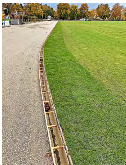
Rollrasen-Streifen auf frischer Rasentragschicht
