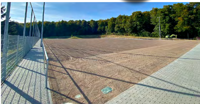
Eingefasst von Ballfangzaun, Wegen und Zuschauerbarrieren ist das Feinplanum fertig zur Ansaat mit vorgekeimtem Sportrasen
