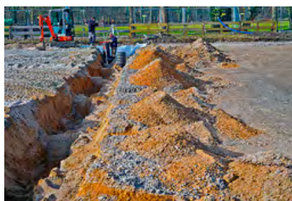
Erdarbeiten für kilometerlange Dränagen
