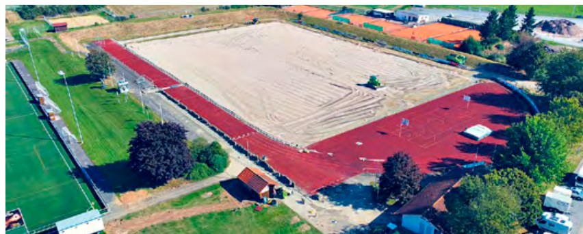
Abtrag der alten Grasnarbe und Erdschichten (Bild oben) und neuer DIN-gemäßer Schichtaufbau
