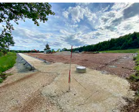
Aufbau eines tragfähigen Baugrunds
