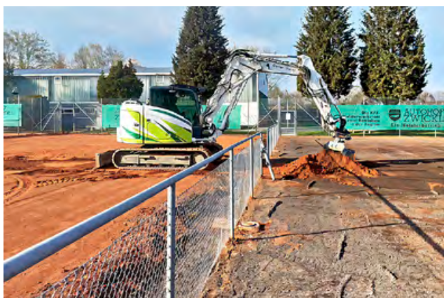
Einbringen der neuen Ziegelmehldeckschichten
