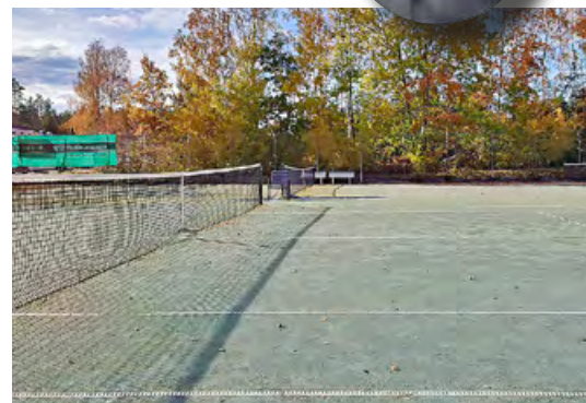
Abgespielte Plätze vor der Sanierung
