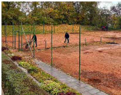
Abbau der Zaunanlage in Eigenleistung
