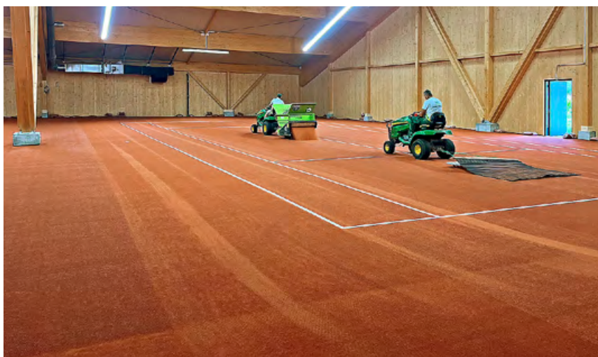
Nach Verlegung der Membrane wird der Keramiksand oder das Ziegelmehl eingestreut
