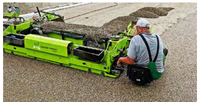
Einbau der wasserdurchlässigen Tragschicht, einem Gemisch aus Gummigranulat und mineralischem Split
