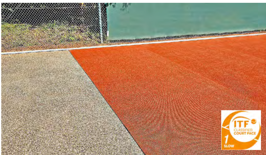
Die langlebige Membrane wird auf einer stabilen wasserdurchlässigen Tragschicht verlegt und mit feinem Keramiksand abgestreut
