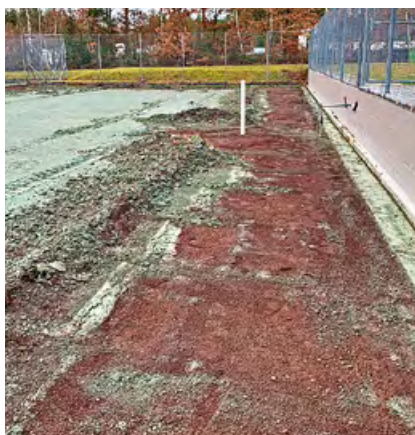
Abtragen der verschlissenen Canada Tenn-Deckschicht
