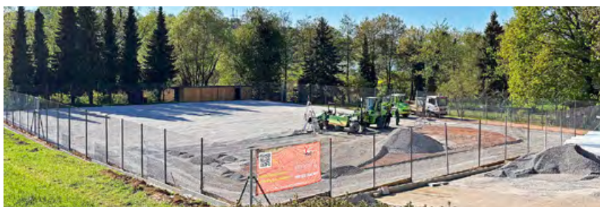
Einbau der Tragschicht als stabiler Unterbau für den Kunstrasen
