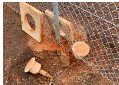
Angleichung der Regner-Einbauhöhen
