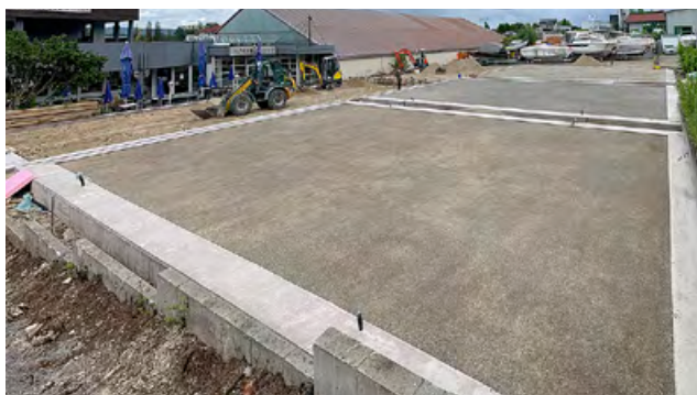
Umfangreiche Erdbau- und Fundamentarbeiten
