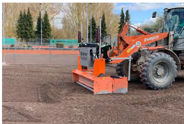
Erstellung des Lava-Planums mit einem Grader-Vorbau
