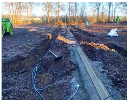
Einbau neuer Entwässerungsrinnen
