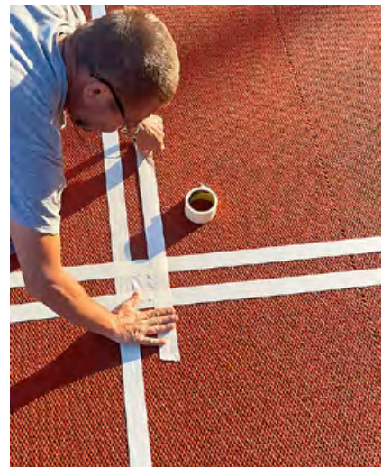
Dauerhafte Linierung auf der wasserdurchlässigen Membrane
